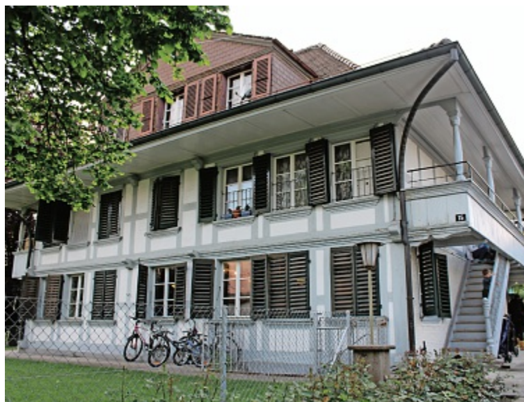
Das ZelgAtelier im alten Bauernhaus an der Zelgstrasse 15.
