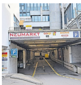
Die Neumarkt-Tiefgarage verfügt über 600 Parkplätze.
